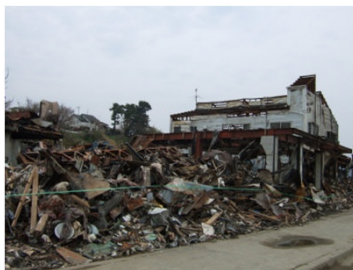
瓦礫が残る石巻市内の様子
